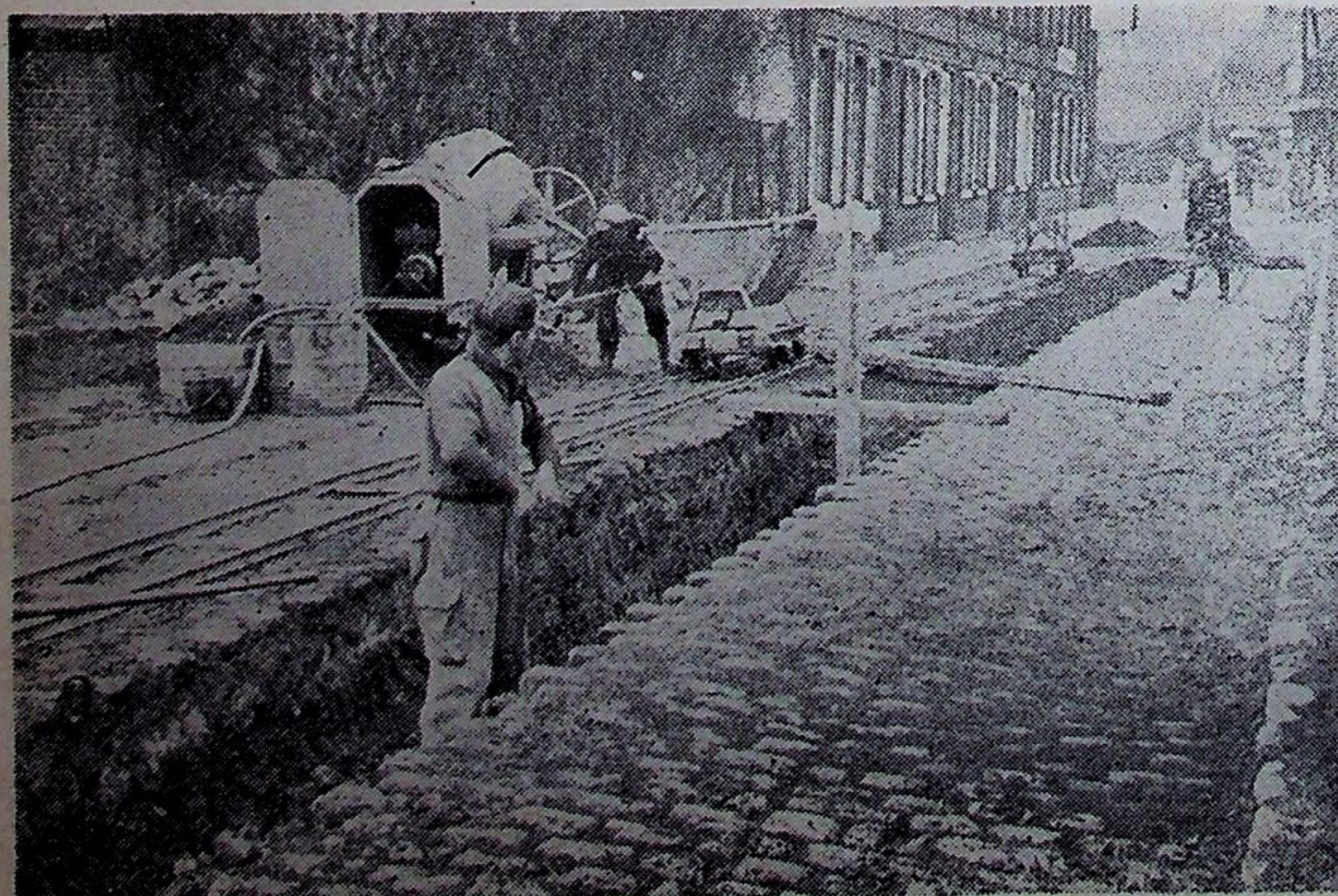
La pose de l'aqueduc se poursuit activement rue du Maréchal-Leclerc.
