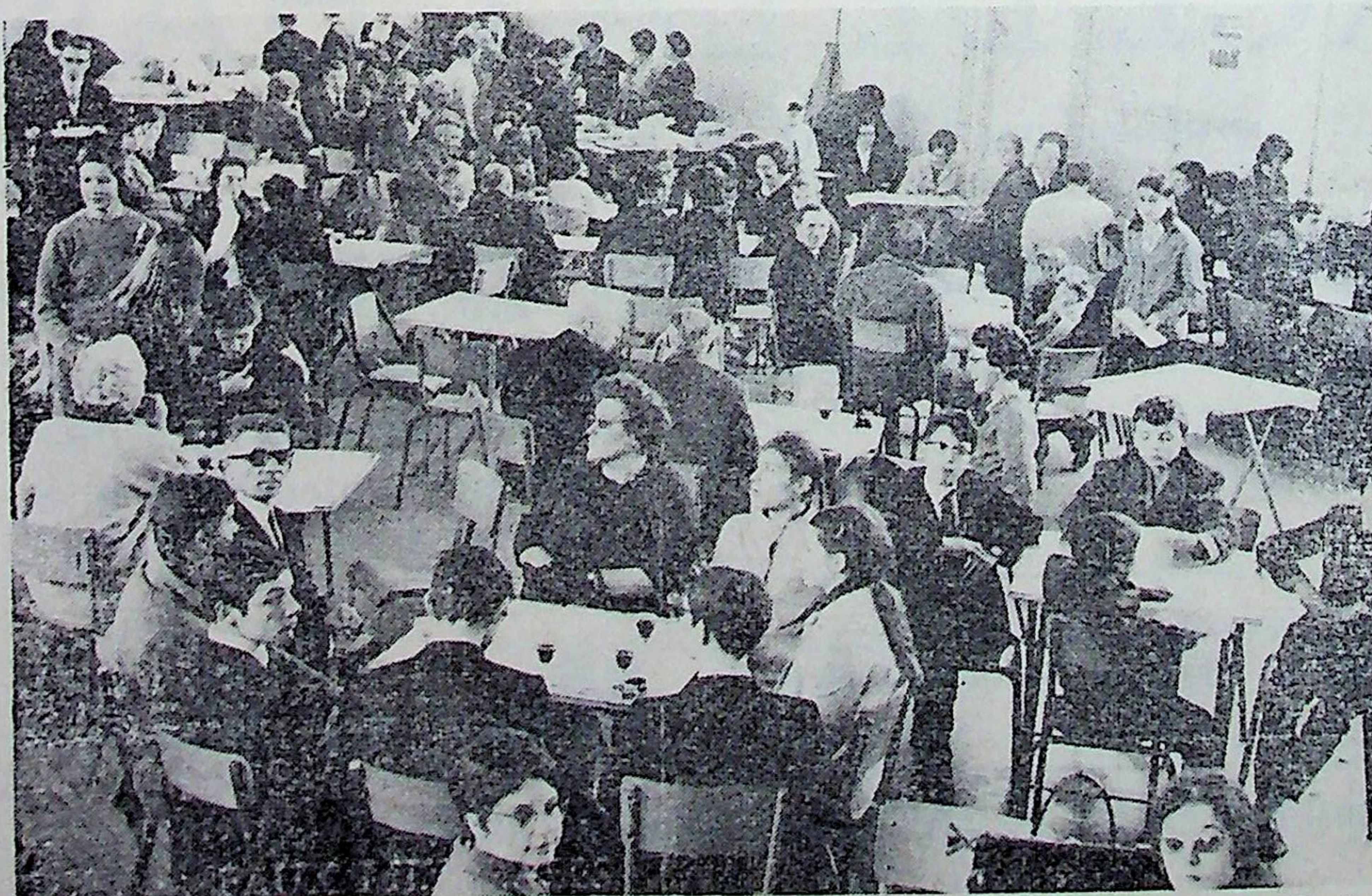
Voici une partie de la salle de l'Estrielle.
