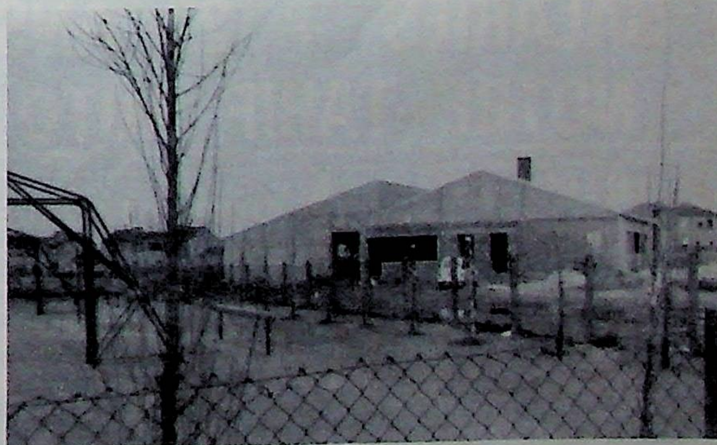
Stand de Tir en construction
